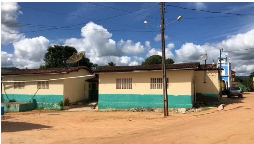
Figura 1. Escola Municipal Santa Terezinha.
